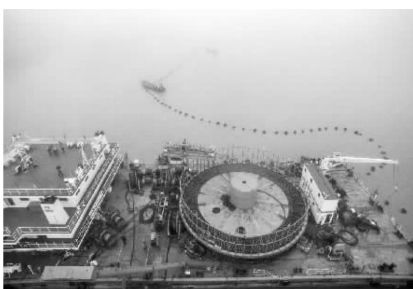
3月16日，最后400多米的海缆从“建缆一号”海缆敷设船上缓缓放入海中，由小船拉上登陆点（航拍器拍摄）。
