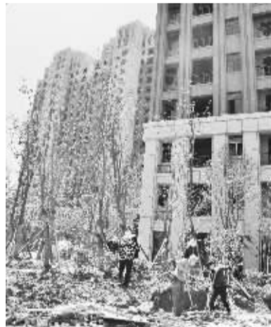
▲园林工人紧张施工。
