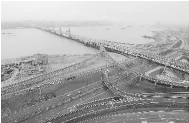
5 月 18 日拍摄的南昌朝阳大桥。 5 月 18 日，南昌朝阳大桥正式通车。朝阳大桥全长 3.2 公里，双向 8 车道。大桥跨越赣江范围全长约 1560 米，分主桥和引桥两部分，桥宽 37 米。朝阳大桥的通车将极大舒缓南昌跨江通道的交通瓶颈，成为真正意义上的城市快速通道。 新华社记者 万象 摄
