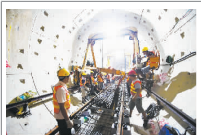
9 月 30 日,在深圳地铁 9 号线 9201 标项目部,工人在铺设轨道下的钢筋。 深圳地铁 9 号线已经进入铺轨阶段,为保障该线路在 2016 年 12 月 30 日顺利开通试运行,建设者们放弃了中秋、国庆双节的休息。据了解,9 号线敷设地段多为繁华市区,需要大量减低噪声污染,因此施工要求高、进度慢、工艺繁杂,为此,施工方投入轨道车 18 辆,全体员工 4000 余人日夜奋战在施工一线保畅通。 新华社记者 毛思倩 摄
