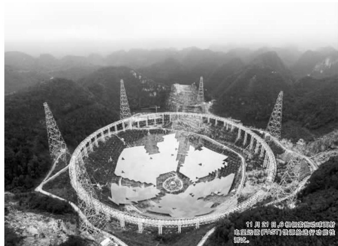
11月21日,6根钢索拖动球面射电望远镜(FAST)馈源舱进行功能测试。
