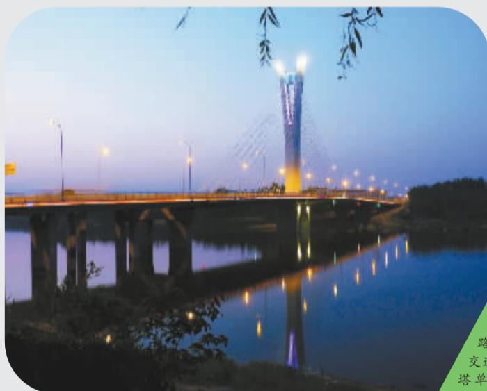
2010年7月2日，周口市沙颍河大庆路桥和改造后的周口大道同日正式通车。大庆路桥是连接沙颍河两岸的重要交通通道，为目前周口市最大的独塔单索面斜拉桥，全长297米，宽35.5米，双向四车道，是周口中心城区的标志性建筑。
