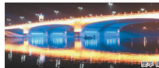
彩虹卧波(沙颍河市区段大桥) 樊华 摄
