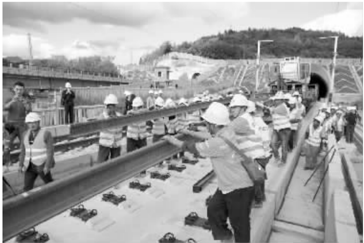
10月15日在四川省广元市境内拍摄的铺轨现场。
