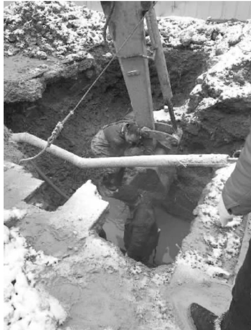
昨日中午,在周口中心城区五一路与黄河路交叉口,周口银龙水务有限公司管网抢修部的施工人员顶着风雪,跳入冰冷的泥水中,进行地下供水管网对接工程。该工程系五一南路供水低压区改造工程,完工后将大大缓解五一南路用户吃水难的问题。
