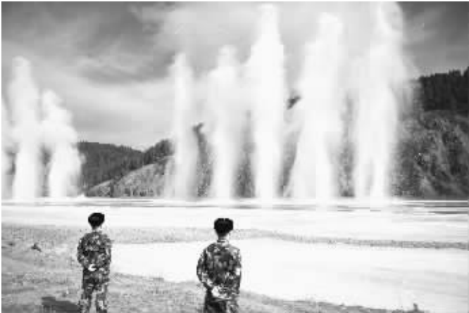
4 月 11 日, 在黑龙江省漠河县北极村, 北极边防派出所官兵在黑龙江破冰爆破现场警戒。 随着天气转暖, 冰封的中俄界黑龙江即将开江, 黑龙江省大兴安岭地区边防、水利、公安等多部门联动, 对重点江段实施冰凌爆破, 防止开江期间险段形成严重冰坝, 引发凌汛。 新华社发
