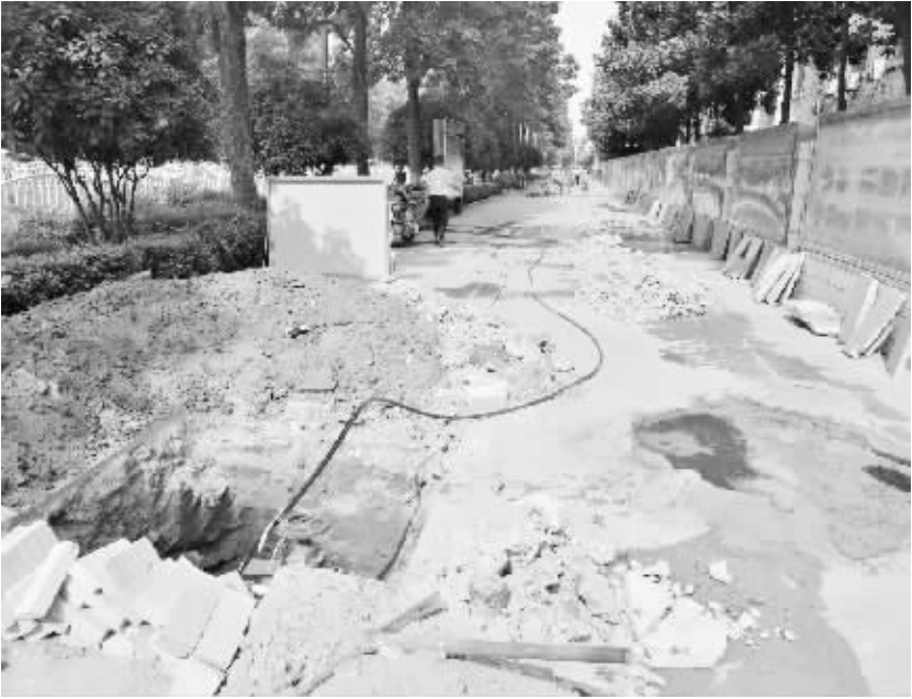
7 月 5 日，周口晚报记者在周口中心城区七一路与八一大道交叉口西侧看到，七一路水网改造工程已经接近尾声，传统地下铁管换成了高强度塑料管。据悉，中心城区水网将陆续更新。 晚报记者 徐松 摄
