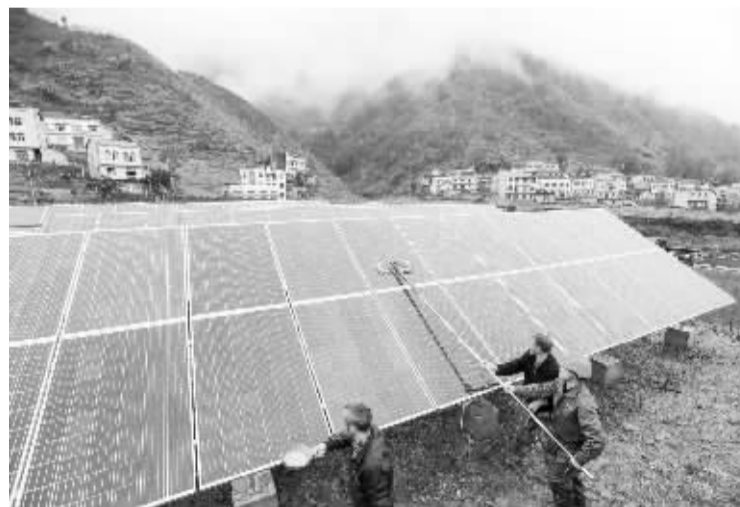
10月18日,重庆市巫溪县桂花村光伏扶贫发电站内,国网重庆巫溪供电公司凤凰供电所的技术员(右一)在指导桂花村的两名贫困户定期清洁光伏发电板上的污物,增强发电效益。
