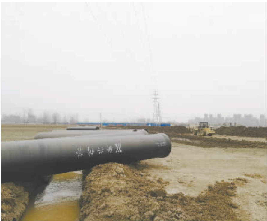
管道铺设施工现场
